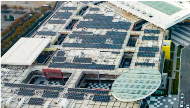
江苏徐州杉杉奥莱屋顶光伏
